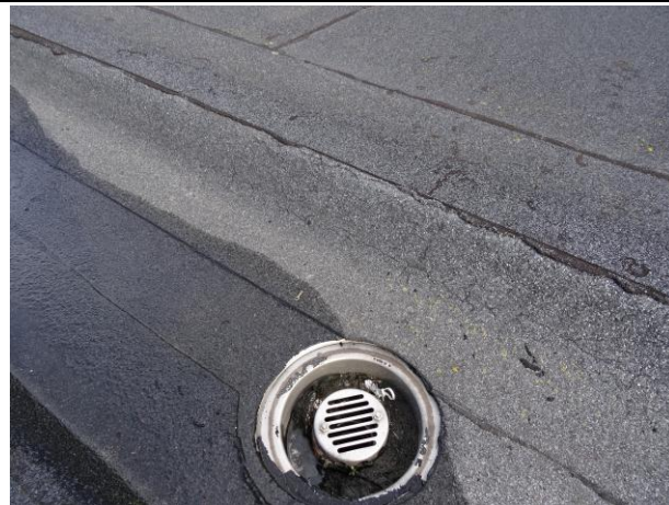
Foto: 5 Tagpap med revner/krakelering
