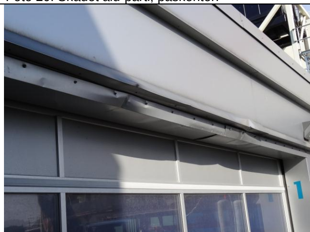
Foto 21: Påkørselsskadede portkarme.
