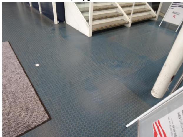
Foto 26: Afbleget gummigulv, dog intakt.
