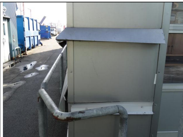
Foto 22: Påkørselsskadede ydervægge.
